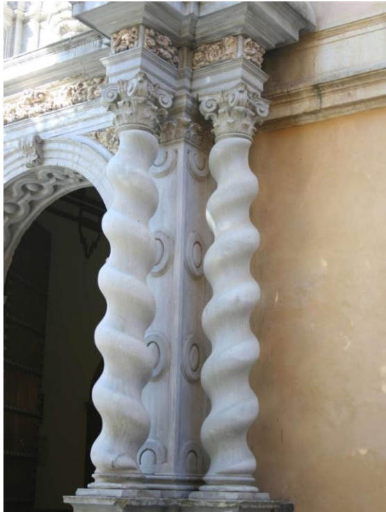
Detalle de la fachada principal. Edificio San Pablo
